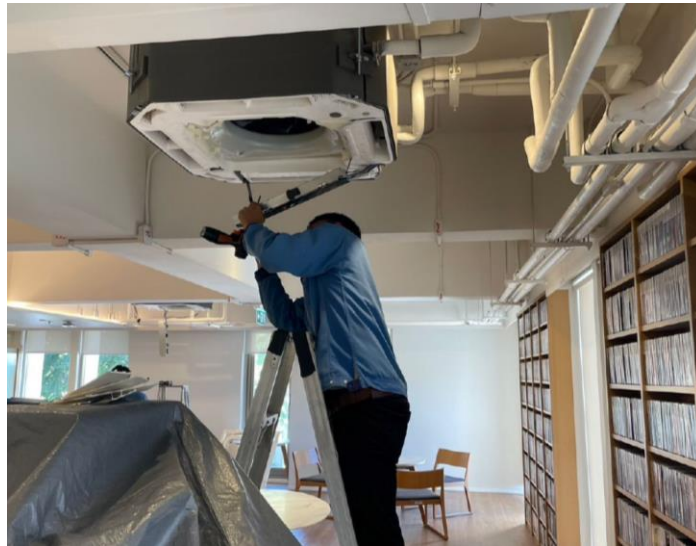
ภาพที่ 10 หน่วยงานที่มีความเชี่ยวชาญดำเนินการตรวจสอบและทำความสะอาดเครื่องปรับอากาศ
