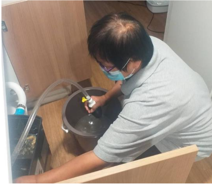
ภาพที่ 2 ผู้รับผิดชอบดำเนินการล้างบ่อดักไขมัน
