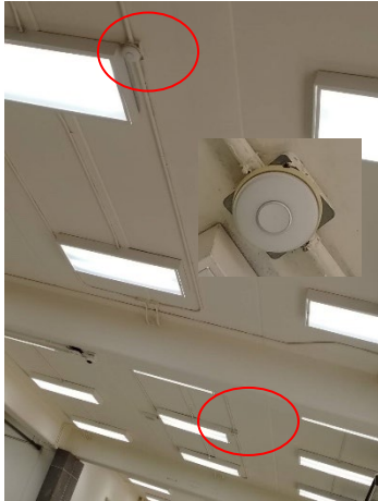
ภาพอุปกรณ์ตรวจจับควัน ( SMOKE DETECTOR ) และชุดควบคุม ( Fire alarm Control Panel )
