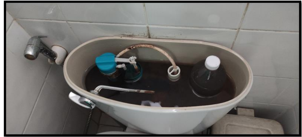
ใช้ใส่ในหม้อน้ำชักโครกช่วยลดปริมาณการใช้น้ำ
